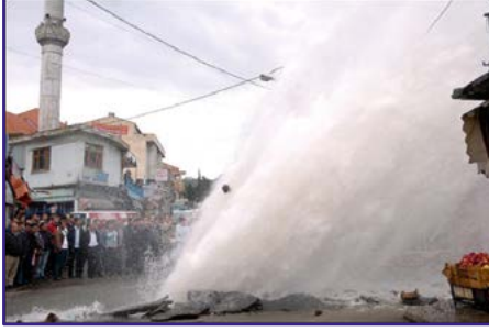
Şekil 8.10. Fazla basıncın düşürülmesi ile arıza oranı azalır.
