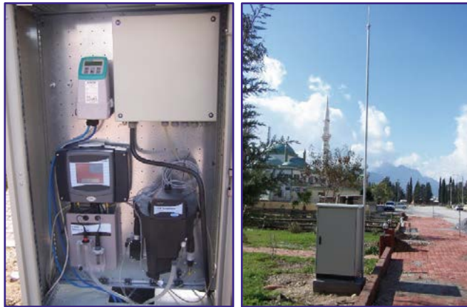
Şekil 9.3. Örnek bir yerüstü yapısına ait görüntüler (debi, basınç, sıcaklık, pH, bulanıklık, iletkenlik ve bakiye klor gerçek zamanlı olarak izlenebilir)
