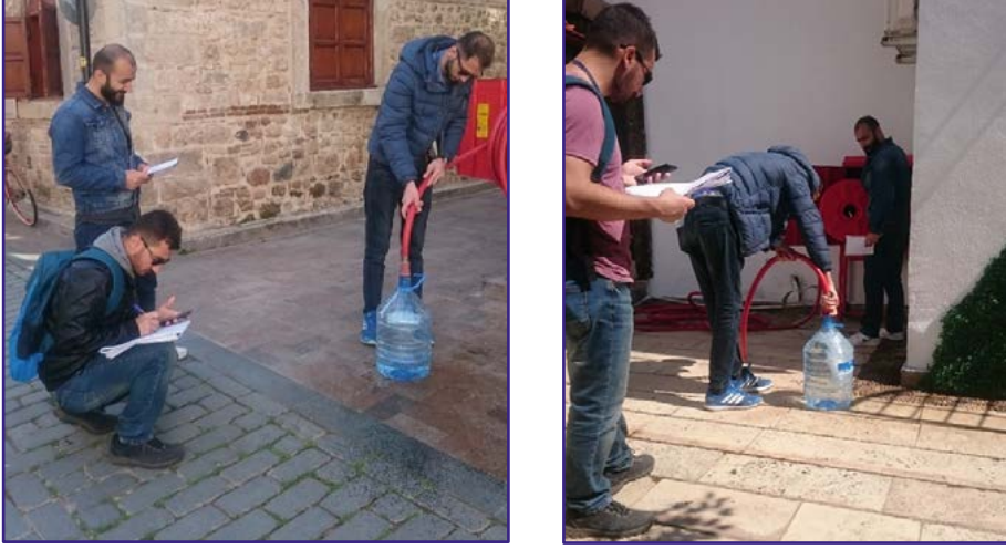
Şekil 6.6. Alt bölge (DMA) girişinde yüksek kotlu bir alanda ve deniz seviyesinde yangın dolapları açılarak debi ölçümü
