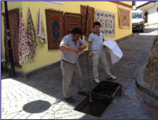
Şekil 5.4. DMA'yı besleyen tüm su vanaları kapatılmalıdır.
