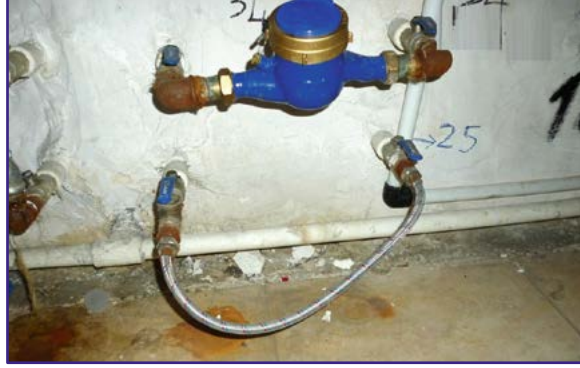
Şekil 1.2. İdari su kayıplarına ait bir görüntü (su sayacına by-pass yapılarak izinsiz su kullanımı)
