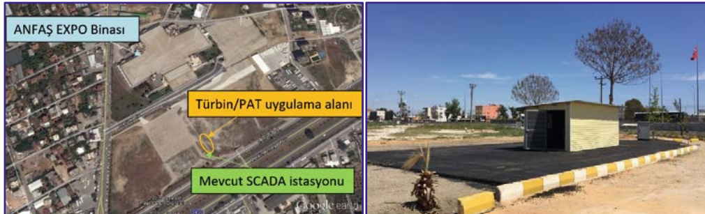
Şekil 8.12. Pompa türbin kullanılarak şebekedeki fazla basınç düşürülür.
