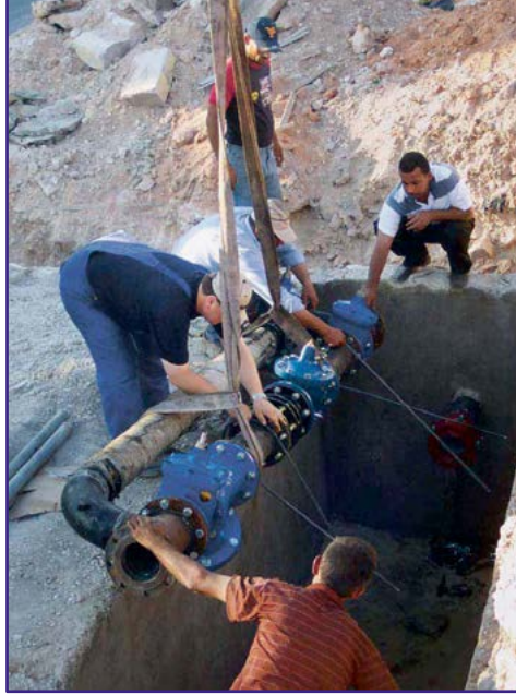
Şekil 1. By-pass borusunun montajı (GWLR, 2011)
