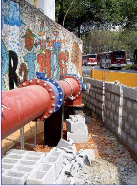
Şekil 3. Basınç düşürücü vana (PRV) montajı (GWLR, 2011)
