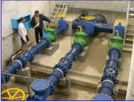
Şekil 8.11. Su basıncının düşürülmesi ile boru/ekipmanların kullanım süresi uzar.
