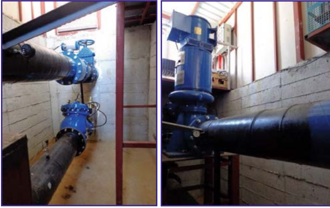
Şekil 8.13. Pompa türbin sistemi bir by-pass hattında kurulmuştur.
