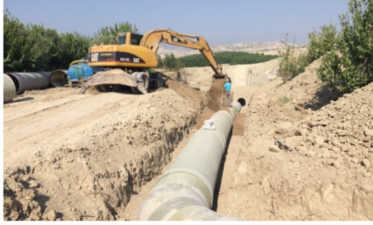
Şekil 34. Kapalı Borunun Hendeđe Döşenmesi İmalatı.
