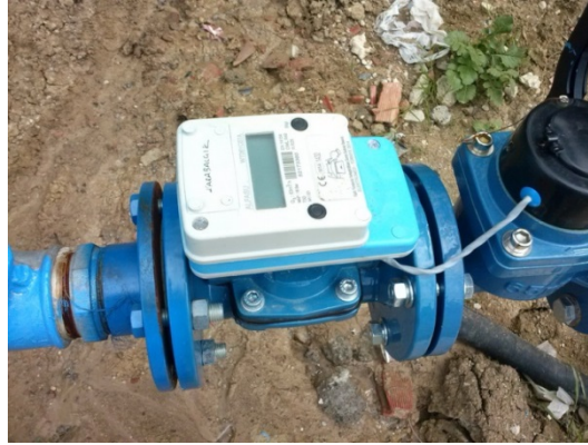
Şekil 35. Yeni Nesil Ultrasonik Sulama Suyu Sayacı.
