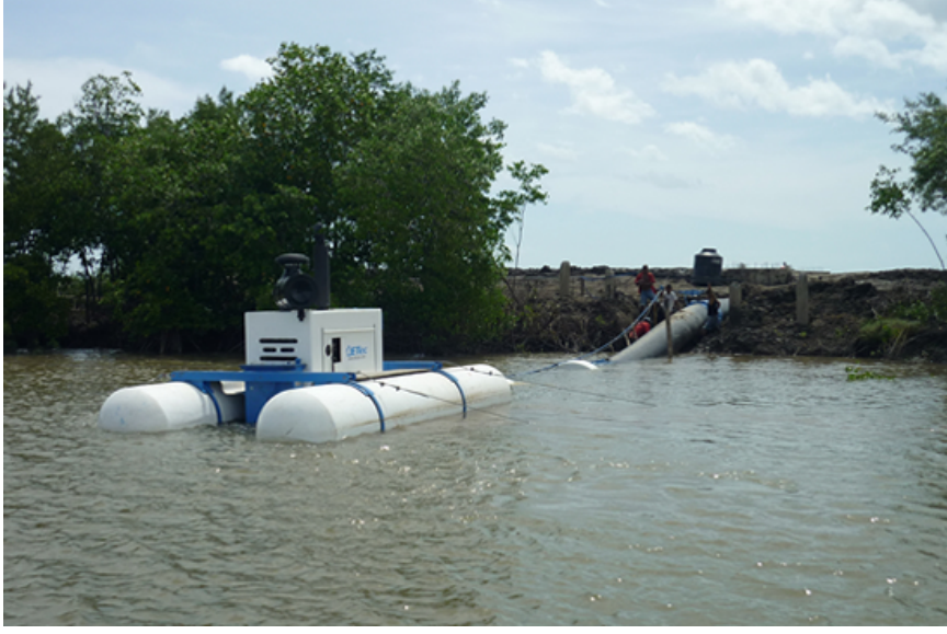
Şekil 12. Yüzen su alma yapısı örneđi.
