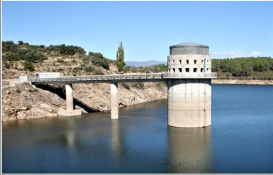
Őekil 6. İspanya'daki Bir Barajda İçme Suyu Kaptajı (URL 1).
