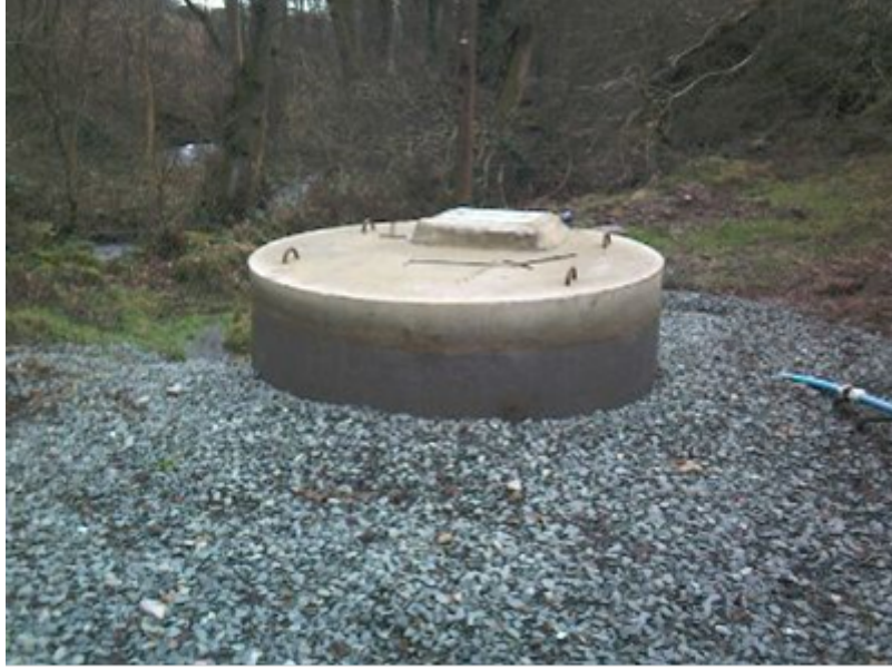
Őekil 7. Bir kaynaktaki İçme Suyu Kaptajı (URL 2).
