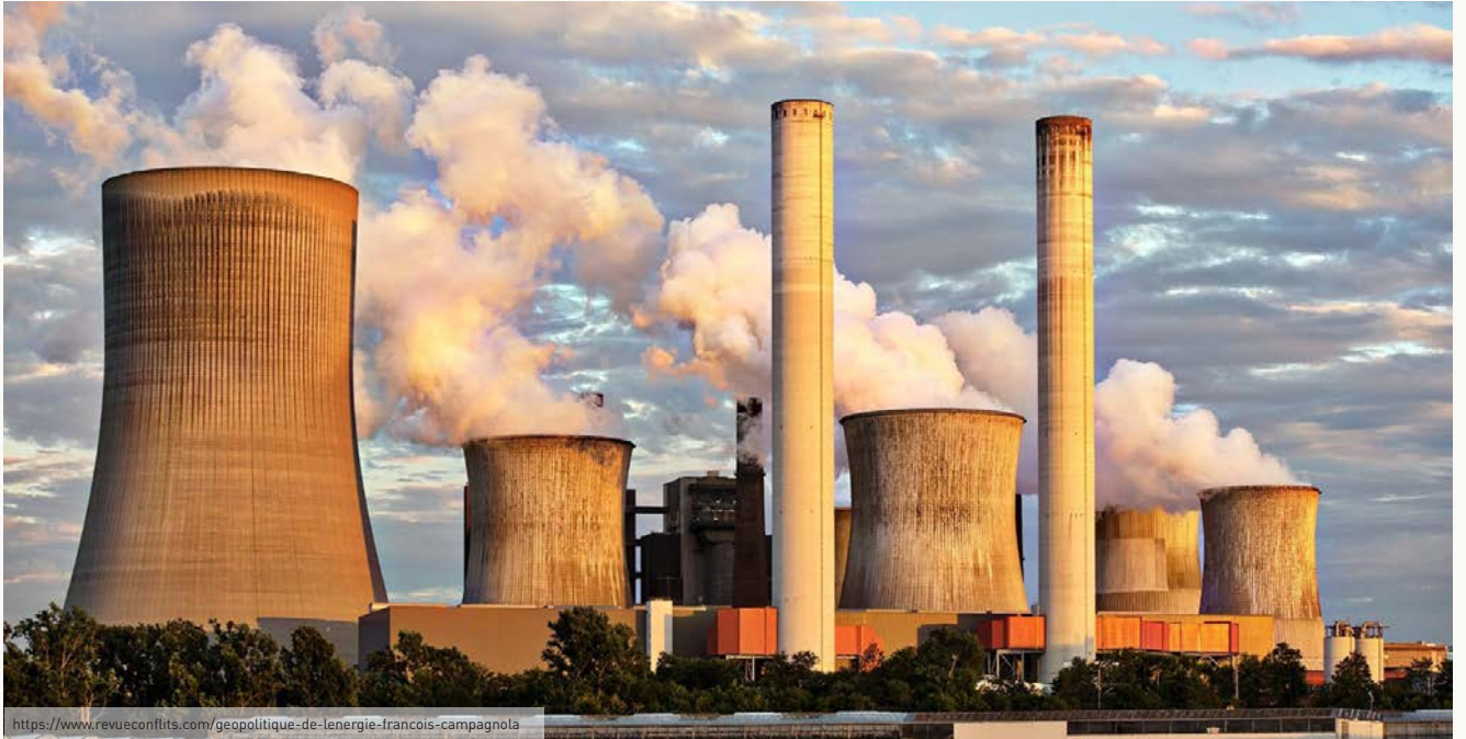
Kule Tipi Soğutma Sistemleri
