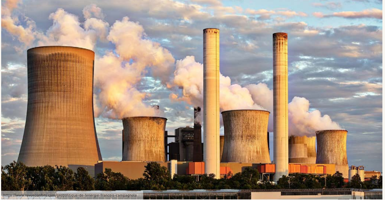
Kule Tipi Soğutma Sistemleri
