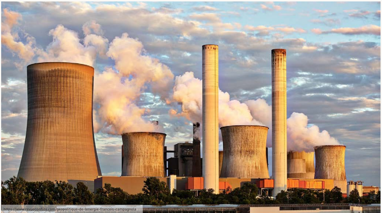
Kule Tipi Soğutma Sistemleri
