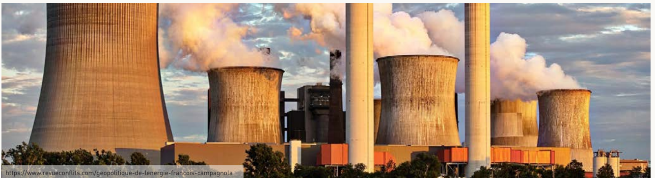
Kule Tipi Soğutma Sistemleri
