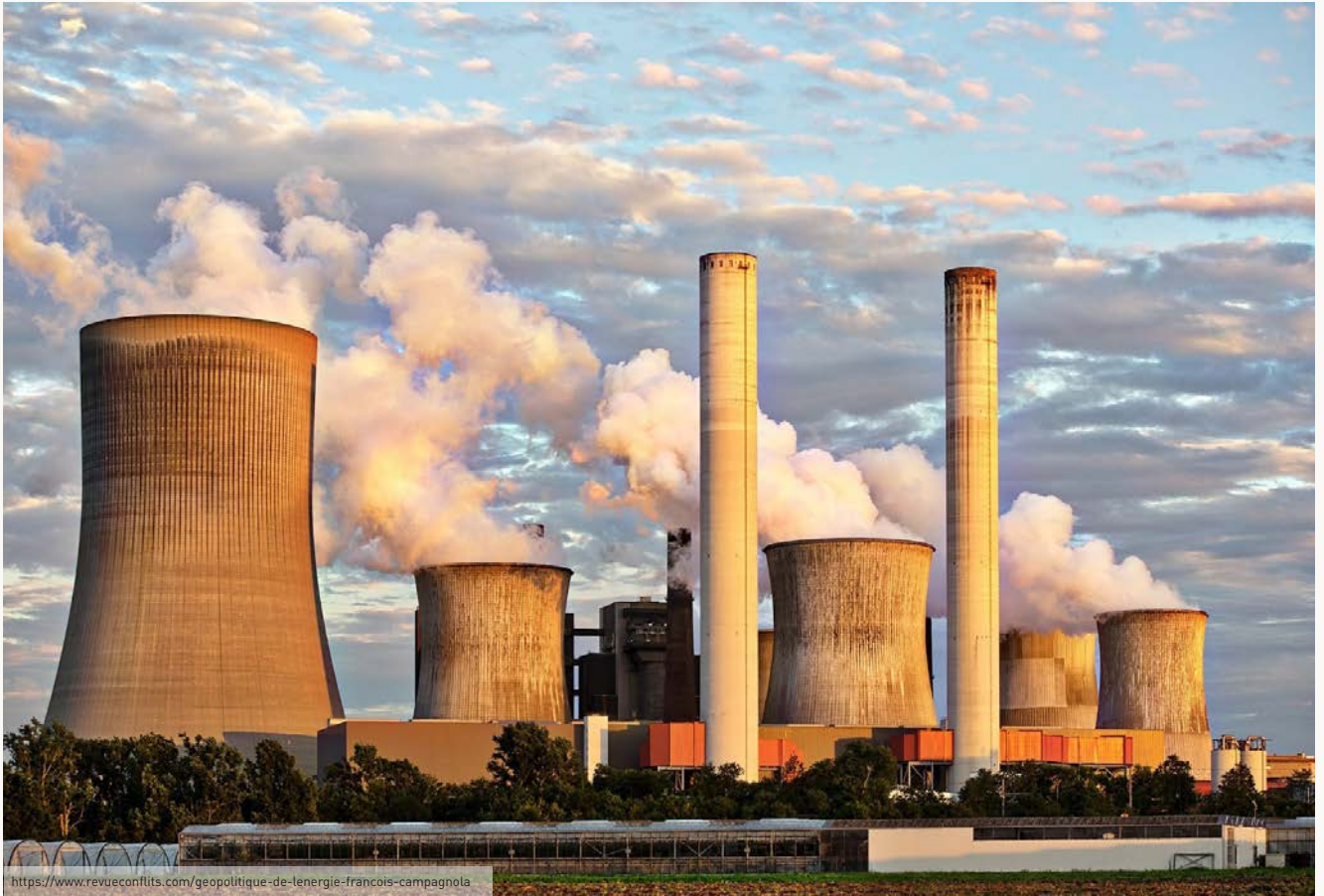
Kule Tipi Soğutma Sistemleri
