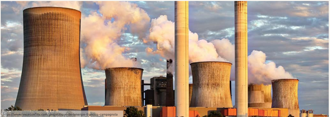
Kule Tipi Soğutma Sistemleri
