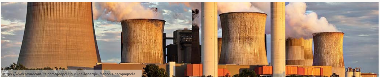
Kule Tipi Soğutma Sistemleri
