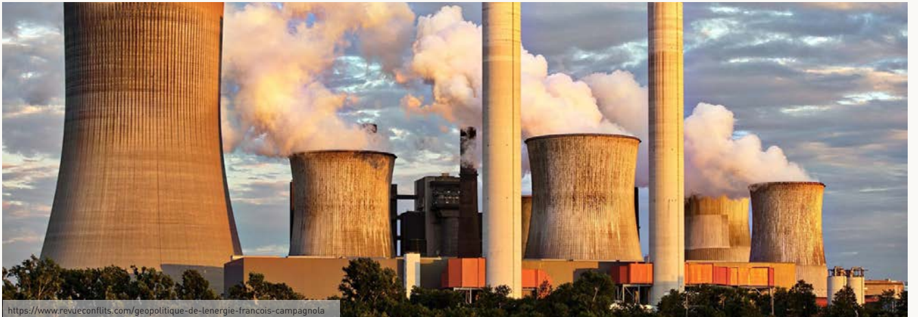
Kule Tipi Soğutma Sistemleri
