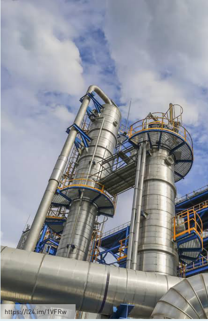
Petrol Rafinerisi Kraking Kolonu
