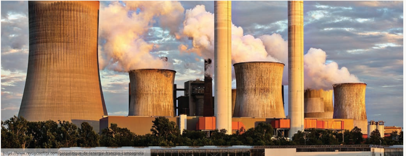
Kule Tipi Soğutma Sistemleri
