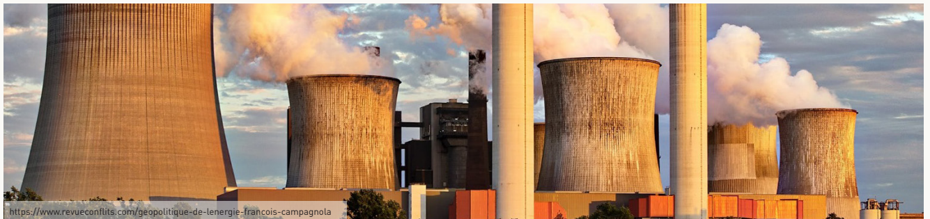
Kule Tipi Soğutma Sistemleri
