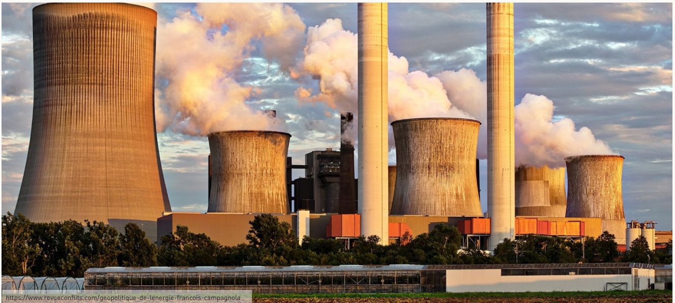
Kule Tipi Soğutma Sistemleri
