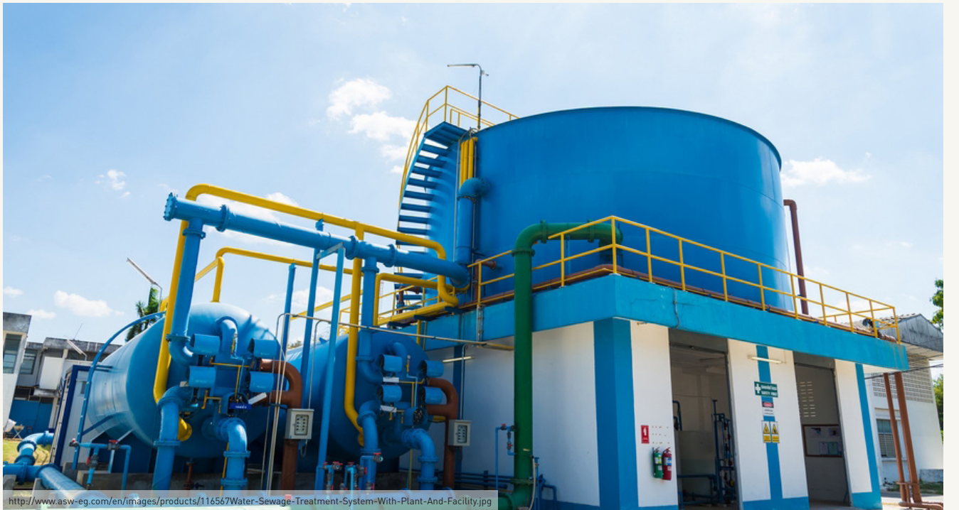
Endüstriyel Atıksu Arıtma Tesisi
