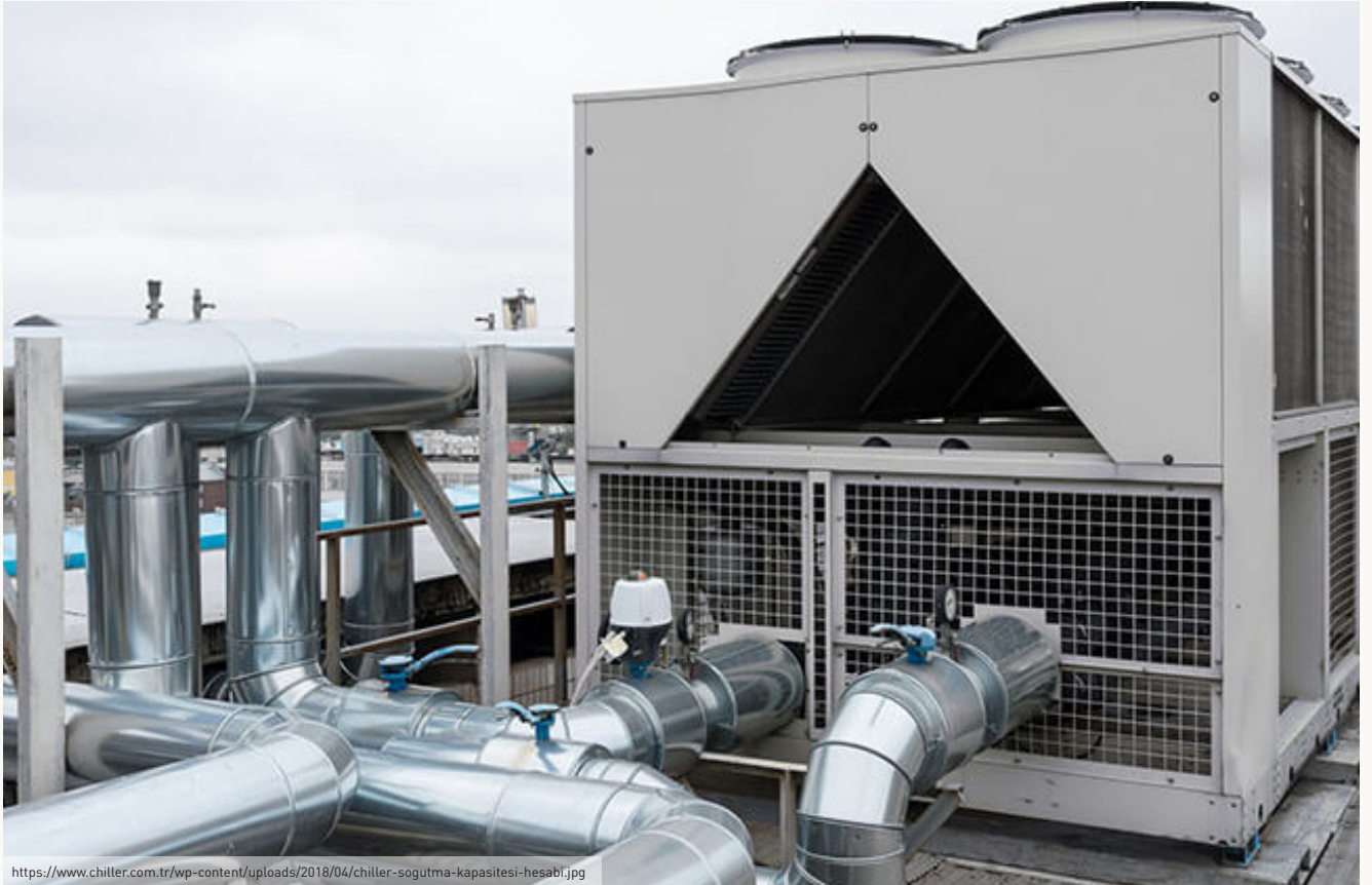
Soğutma Sistemleri (Chiller)
