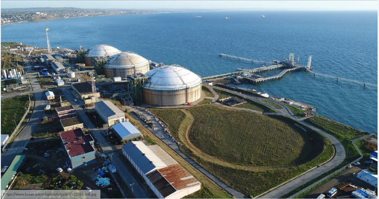
LNG Gazlaştırma ve Depolama Tesisi
