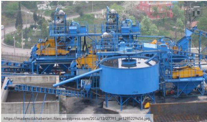
Kömür Zenginleştirme - Lavvar Tesisi
